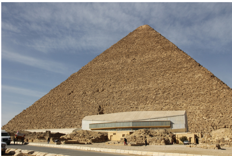
Fig.20 太陽の船博物館（ピラミッド手前の白い建物）
