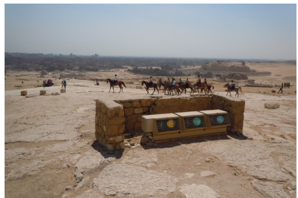
Fig.26 サウンド&amp;ライトの照明設備
